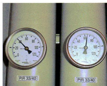
Anlegethermometer mit Sockel ermöglichen die durchgehende Dämmung. Die Mehrkosten sind marginal.
