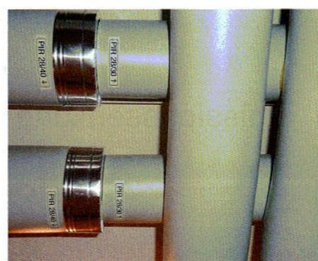
Bei Kreuzungen können nach MuKEN die Dämmstärken reduziert werden. *Une moindre épaisseur de l'isolation thermique est justifiée, p. ex. en cas d'intersections.*
